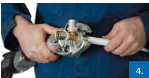
**Abbildung 4: Verpressung / Beenden des Pressvorgangs**
