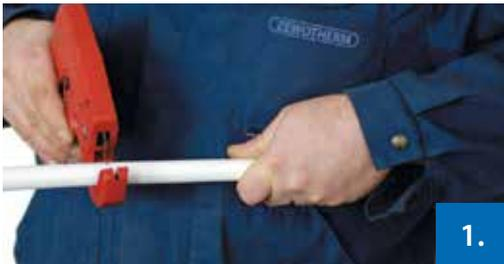
**Abbildung 1: Ablängen des Rohres**
