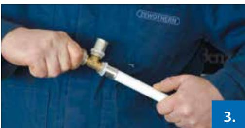
**Abbildung 3: Einsetzen des Fittings**
