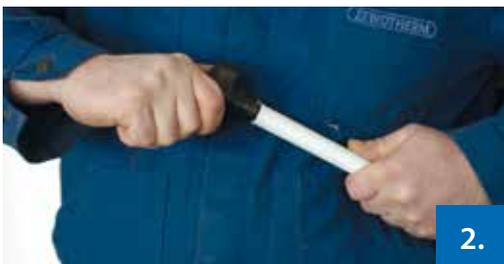
**Abbildung 2: Kalibrierung und Entgraten des Rohres**
